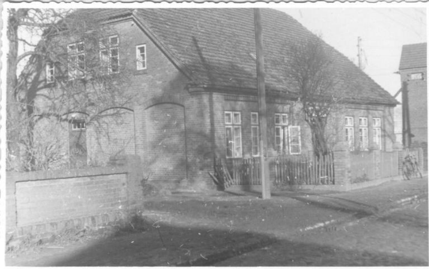
Ehemaliges Schulgebäude in Lüttow (Aufnahme 1960)
